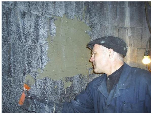
битума, остатков краски, цементного молочка, высолов. Трещины расширяют, старый непрочный бетон удаляют, освобожденную арматуру чистят от ржавчины. Подготовленную поверхность очищают от пыли с помощью сжатого воздуха, промывают водой либо обрабатывают с помощью пескоструйной установки. Необходимо обработать полимерно-минеральной грунтовкой (например, [ПрС 03](#)) слабые и сильно впитывающие влагу основания. Металлические детали должны быть обработаны антикоррозионным раствором.
