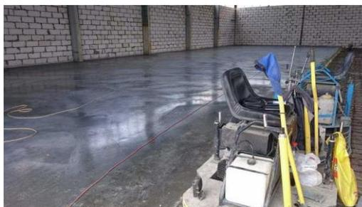
загрязнений. Предотвращает растрескивание поверхностей от попеременного замораживания – оттаивания. Выявляет натуральный цвет камня — эффект «мокрого камня». Применяется в качестве верхнего слоя по химически окрашенным бетонным полам с целью защиты и повышения интенсивности окраски. Применяется как внутри, так и снаружи помещений.
