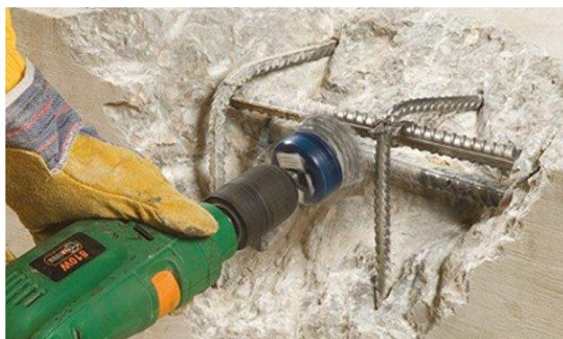
строительной конструкции до плотного крепкого состояния, от пыли, грязи, обезжиривается. Хорошо просушивается и обмазывается свежеприготовленным раствором грунтовки ГрМ.
